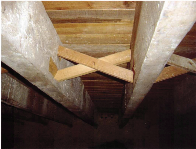
Fig. 2 - Tarugamento do pavimento de madeira através de duas diagonais
